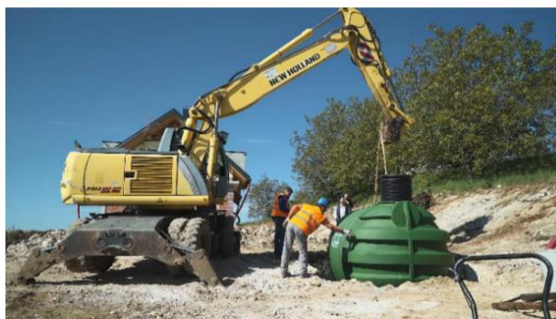
Photo 3 : Installation du réservoir
