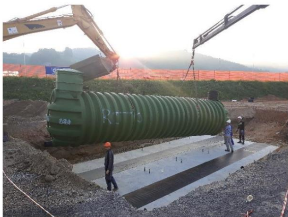
Photo 4 : Installation du réservoir
