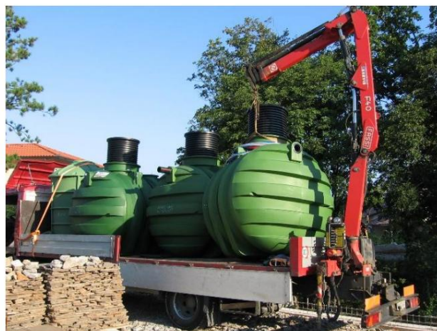
Photo 1 : Transport et déchargement corrects
